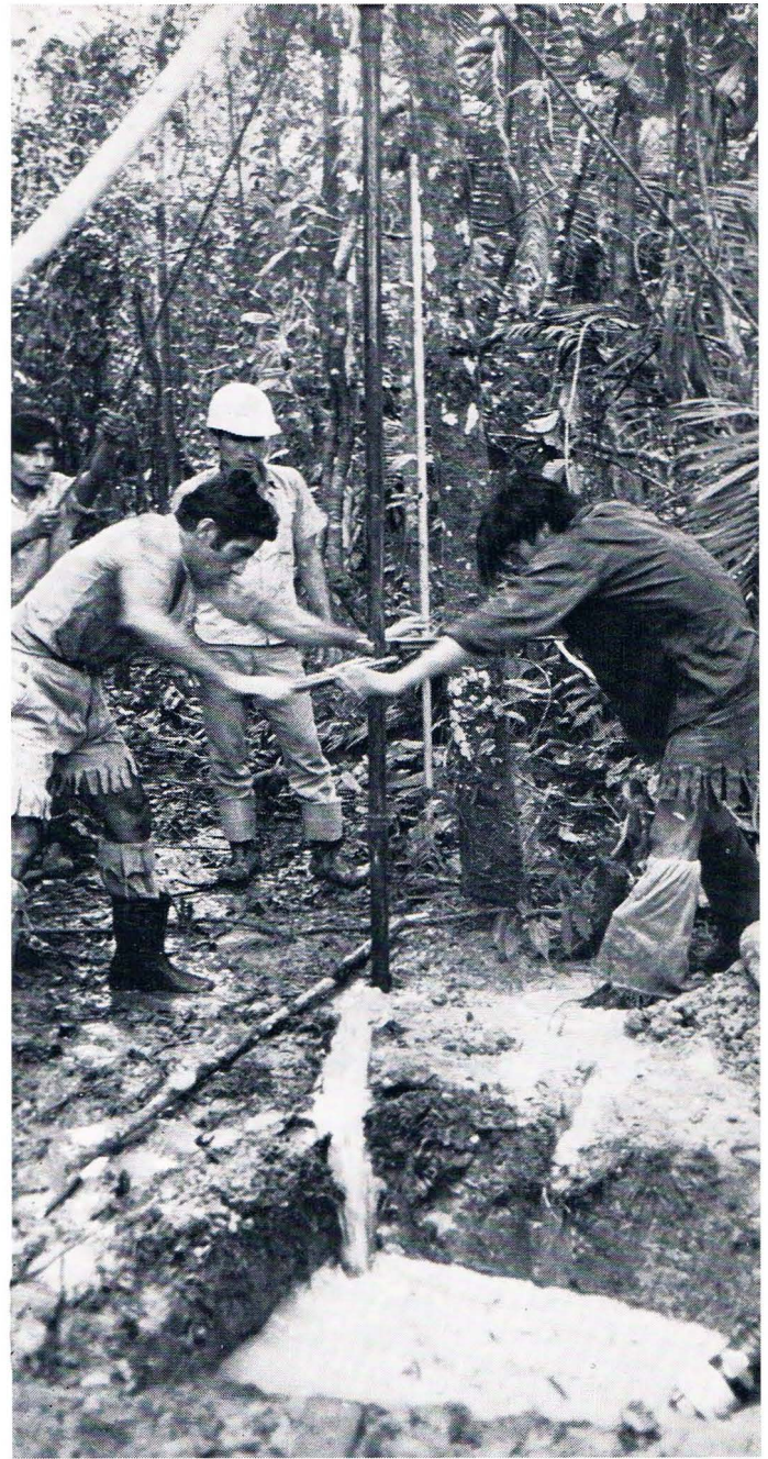
Niederbringen eines Schußbohrloches, Tiefe meistens 16 m
