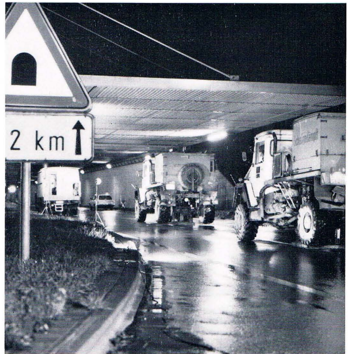
Oströhre des Belchentunnels, Länge 3,2 km, Südportal
