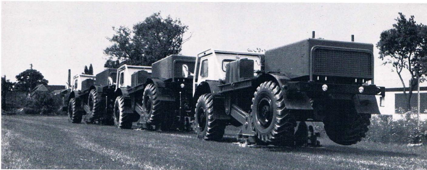
*Zu Beginn der 60er Jahre wurden für die Reflexionsseismik mehrere Verfahren entwickelt, deren Ziel es war, vom Sprengstoff loszukommen und als Energiequelle mechanisch erzeugte Impulse zu verwenden.*
