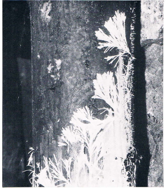
Pilzbewuchs an einem Holzstempel im Hella-Glück-Stollen
