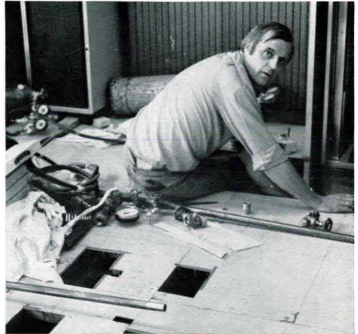
▲ Meister Engel verlegt Wasserrohre größeren Durchmessers für die Kühlung der CDC 175 Mr. Engel assembling new piping of larger diameter for the cooling system of the CDC 175
