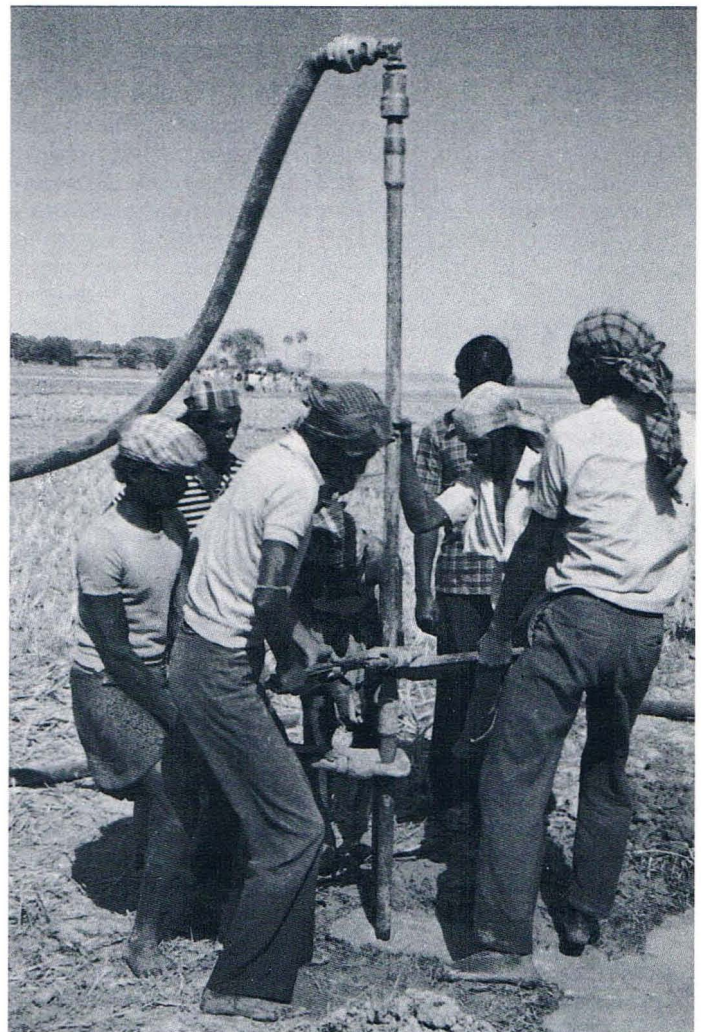
Bohrarbeiten in einem trockenen Reisfeld Drilling operation in a dry rice field
