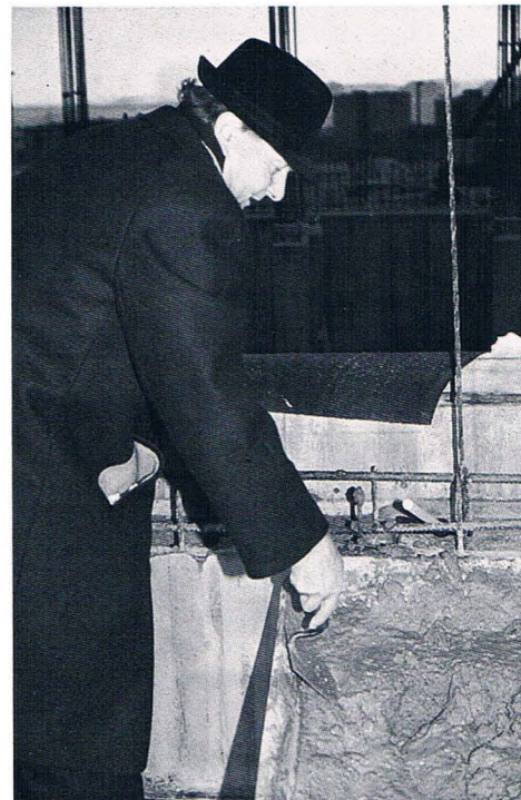
Dr. H.-J. Trappe beim Einbetonieren der Bau-Bulle
