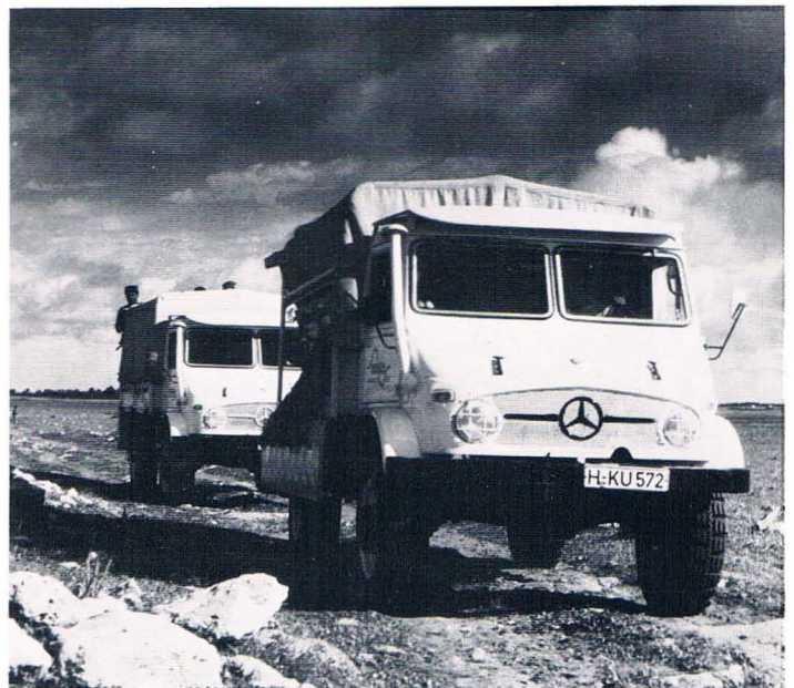
Anno 1962: zwei Kabelwagen UNIMOG-S im Einsatz 1962: two UNIMOG-S cable trucks in operation
