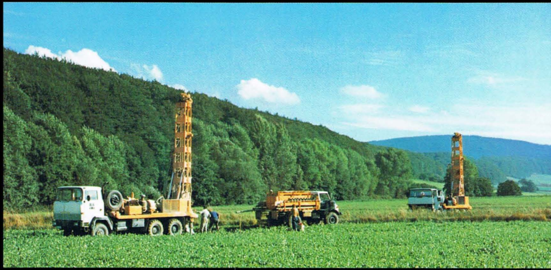
Schwere Bohrgeräte im Einsatz Heavy drilling rigs in operation
