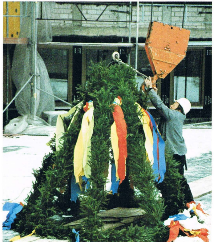
Der Richtkranz wird befestigt
