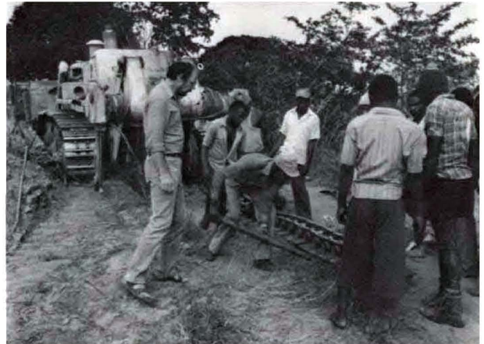
Caterpillar-Reparatur vor Ort • Caterpillar repairs on the spot
