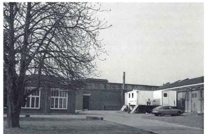
Auf dem Fabrikgelände in Oldenzaal At the industrial site in Oldenzaal
