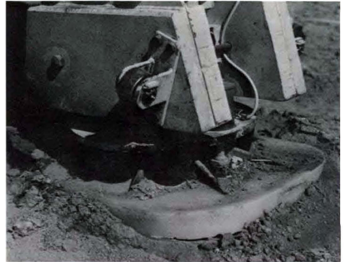
Die Bodenplatte • The base-plate
