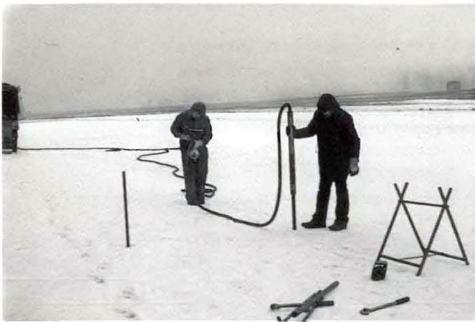
◁ Winteridylle mit Rammhammer Winter setting with ram hammer
