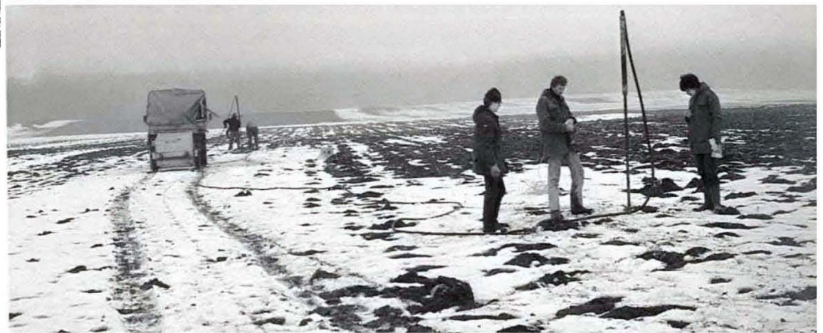
Zwei Rammhämmer von einem Kompressor betrieben Two ram hammers operated by one compressor ▽
