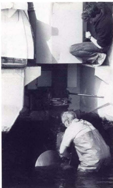
*Ein Fischernetz wird aus der Schraube entfernt. . .
