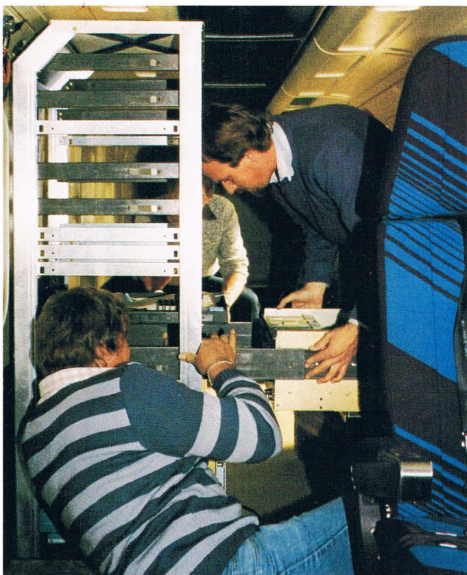
Ausrüstung des Geräte-Racks II Equipping the rack II
