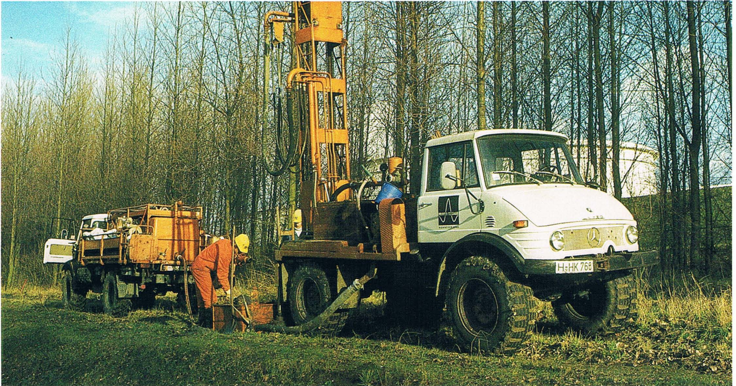
Eine Unimog-Bohreinheit auf dem Punkt Unimog drilling unit on site
