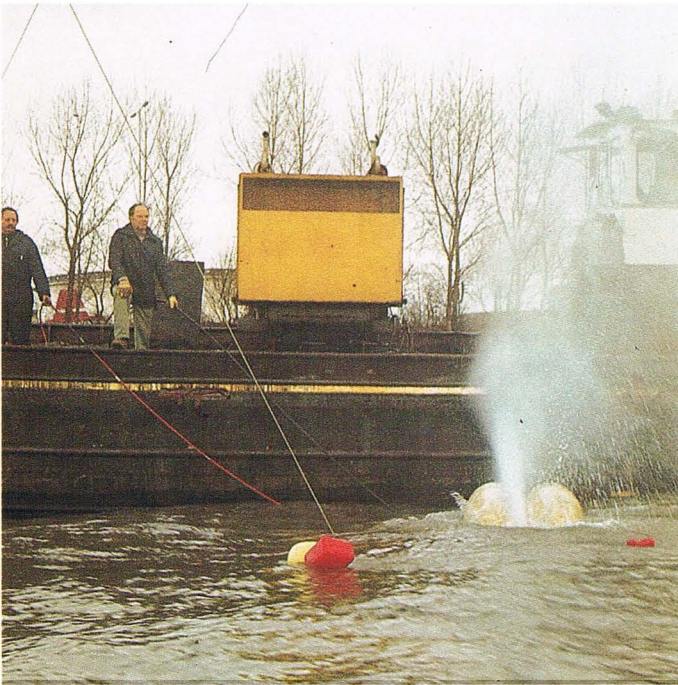
◁ ... und der Schuß über ein ZXDD auf der Brücke des Schiffes ausgelöst. Zur Verbesserung der Energieausbeute empfiehlt sich eine vertikale 4- bis 6fach-Stapelung.
