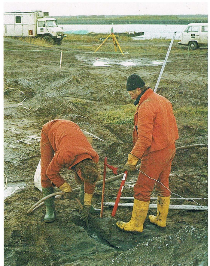
An geeigneten Stellen wird die Ladung eingespült If possible the holes are flushed for the charges
