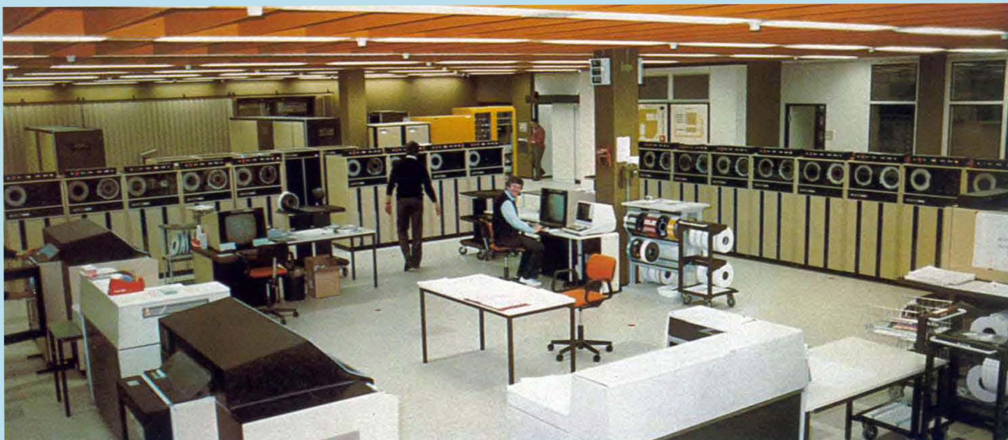
Datenzentrum (Ausschnitt) Data Centre (partial view)
