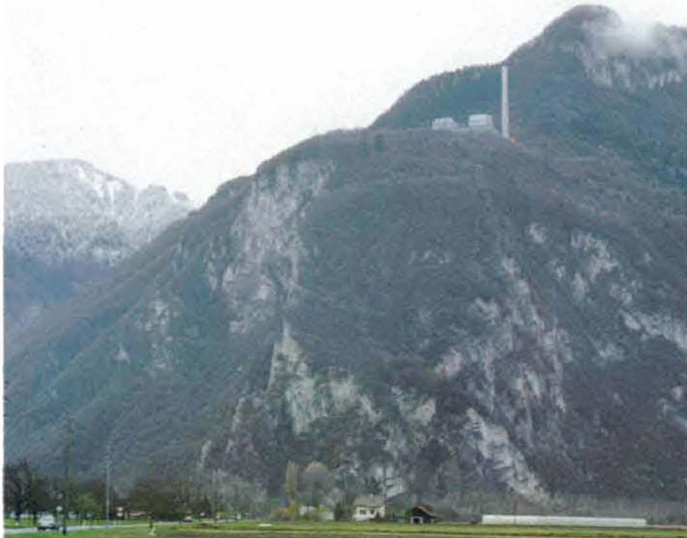
Der zu überwindende Steilhang, rechts daneben das Kraftwerk Chavallon oberhalb von Porte de Sex
