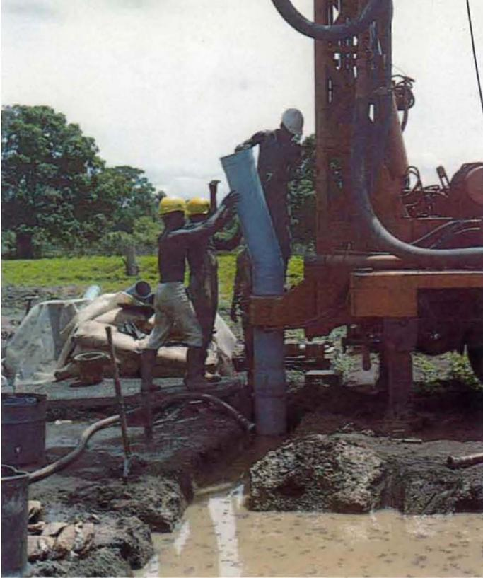
*Einbau von Casing-Rohren bei einer Brunnenbohrung in Guinea-Bissau (Gerät RB 40)*
