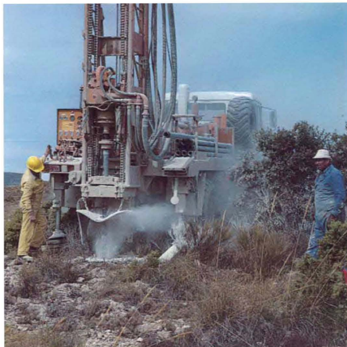
Schweres Bohrergerät P 5001 im Kalkgestein nördlich von Burgos (Paramo de Masa) Heavy drilling rig north of Burgos
