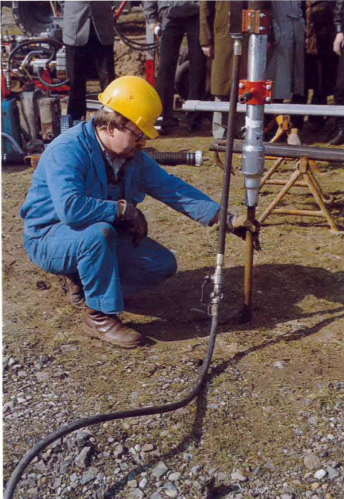
Auch die 'kleinen Systeme' fanden starke Beachtung. Hier schlägt sich ein Rammhammer in den Grund
