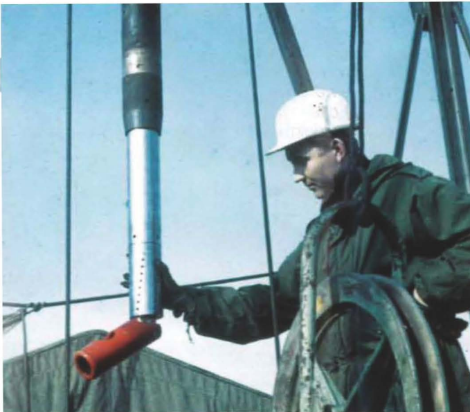
Sondentest vor dem Einfahren (Kiel 1967).
