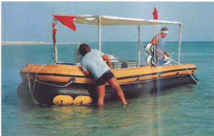
Auslegen der GEOFLEX-Sprengschnur in seichtem Wasser Rolling out the detonating cord in shallow water
