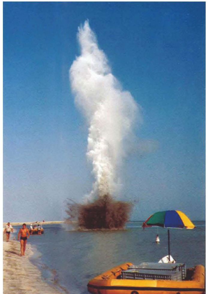
Ein Punktschuß – Die Sprengschnur wurde hier auf der Rolle gelassen
