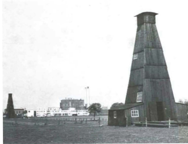
Werksanlage der KNZ in Hengelo mit zwei typischen Holztürmen, wie sie früher über jeder Kaverne aufgerichtet waren.
