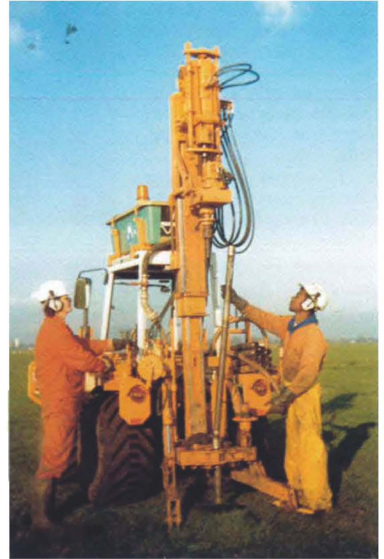
Einsatz der P 0152 in Holland. P 0152 drilling in Holland.
