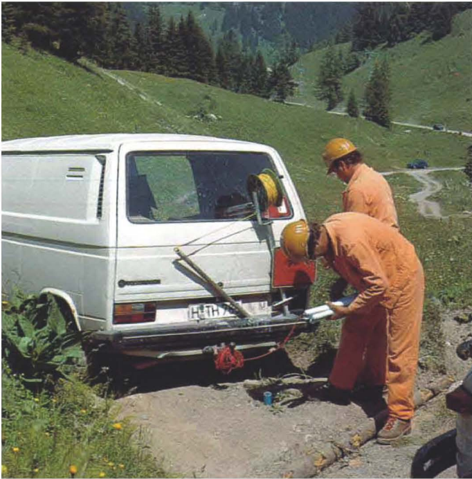
Ein Bohrloch wird durch die Casingrohre mit Sprengstoff besetzt. A borehole being charged through the casing.
