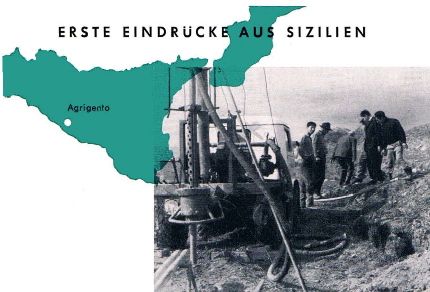
Hangrutsch während des Bohrens
