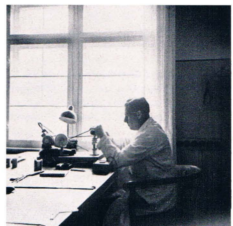
Wickeln einer Spule im Labor
