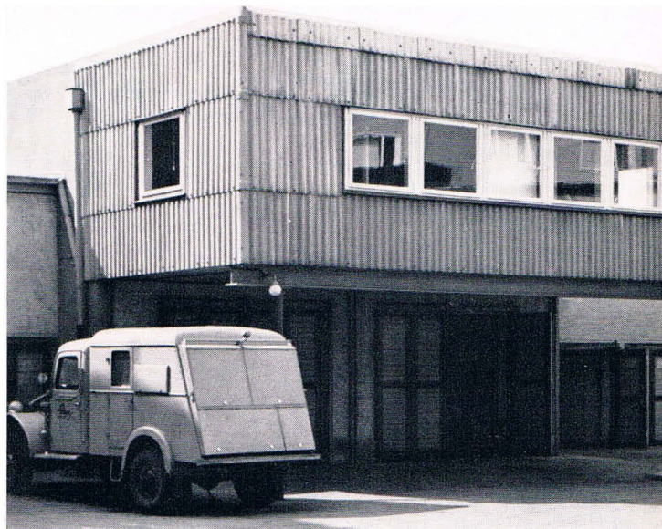
Der „Starenkasten“, in dem das Konstruktionsbüro untergebracht ist
