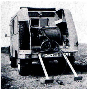
Titelbild: Foto H. Heberger Neuester Bohrlochmeßwagen Typ UNIMOG S der Sondermeßgruppe PRAKLA-SEISMOS
