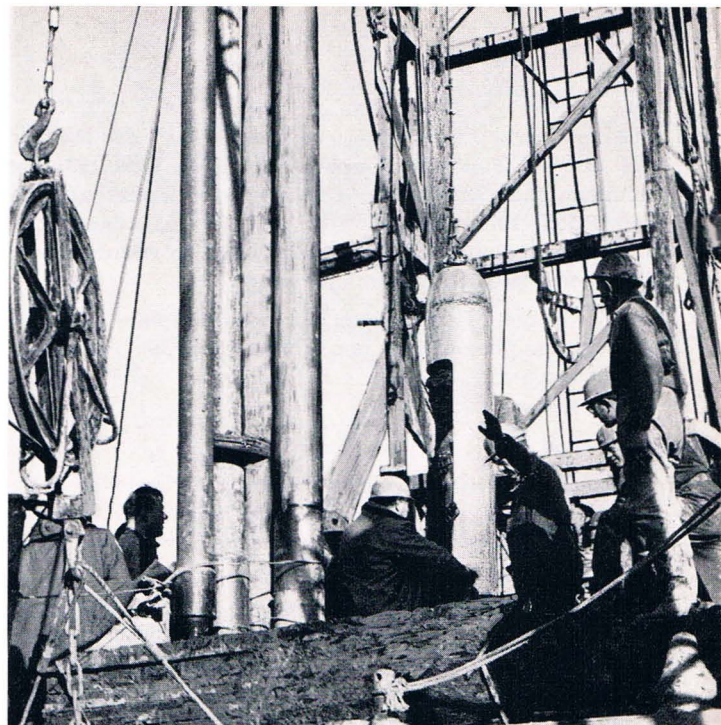
Die Rettung der Eingeschlossenen mittels „Bombe“
