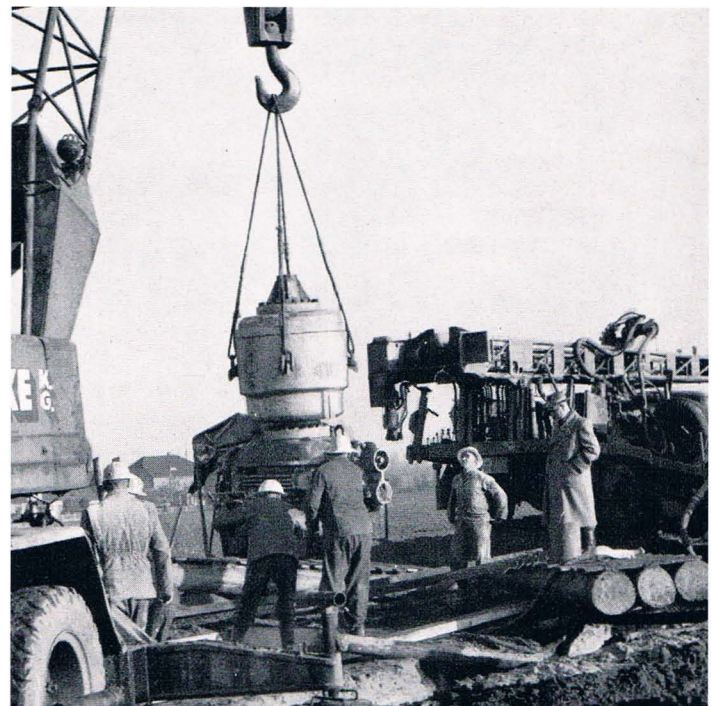
Einbau des Preventers auf Suchbohrung Nr. 13
