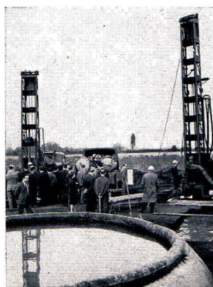
Teilnehmer am Kongreß der Internationalen Assoziation der Hydrogeologen besichtigen ausgestellte Bohrgeräte. Links: Bohrgerät BR/BH 25 für Baugrund- untersuchungen Rechts: Saugbohranlage S 63 für Bohrbrunnen
