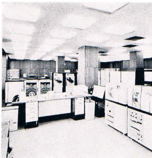
Foto: Heberger PRAKLA-SEISMOS- Rechenzentrum Rechenanlage NE 503 mit peripheren Einheiten
