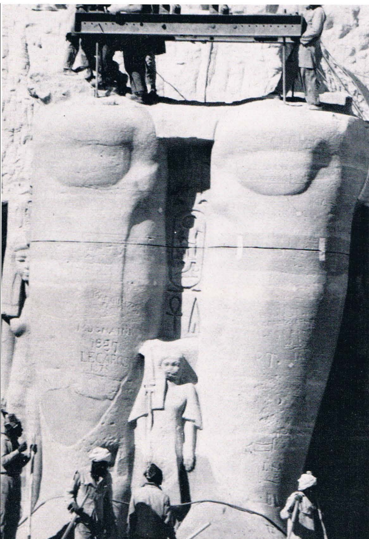
Abb. 10: Die Kniepartie einer der Ramsesstatuen vor der Fassade des großen Tempels, fertig zum Abtransport (man beachte den Sägeschnitt unterhalb der Knie)
