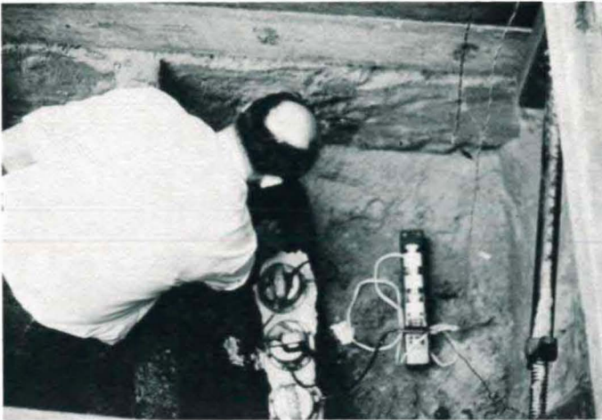
Messungen des Gutachters an Rohrleitungen
