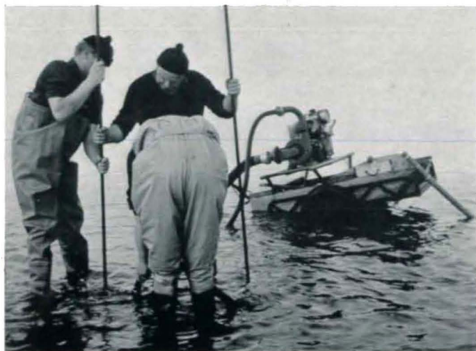
Spülbohrarbeiten mit Wattkarren
